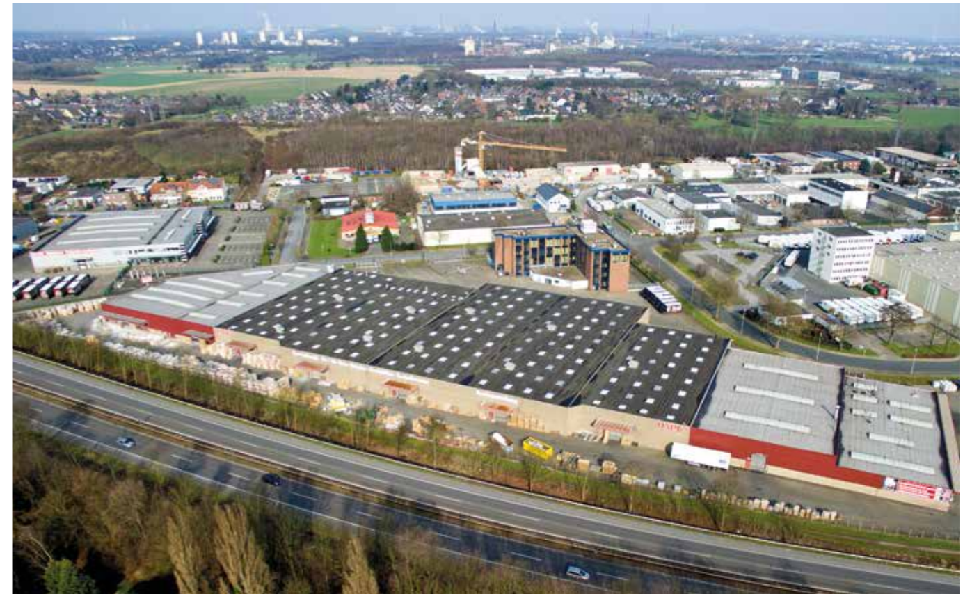
HARK-Zentrale, Entwicklungslabor und Designzentrum mit Produktions- und Lagerflächen am Hauptstandort in Duisburg
